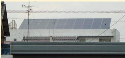
2007年3月より弊社本社の屋上に設置中のソーラーパネル。離れた場所からでもよく見えるため、企業PRにもなっています
