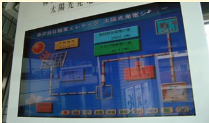
弊社が導入したシステムは10kwの発電が可能。玄関には太陽光による発電がリアルタイムでわかるように発電データを設置しています
