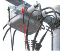
▲写真は、電柱（構内第一柱）に取付けられた高圧区分開器
