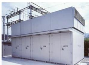
▲NAS電池用交直変換装置
