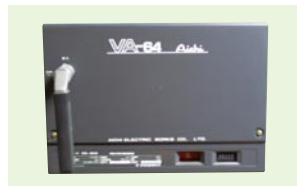
写真③ 遮断器 負荷電流や過電流継電器と組み合わせて、過負荷・短絡電流の遮断を行う機器です。 (例)VCB OCRなど
