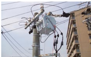
写真① 区分開閉器 電気保安上の責任分界点に設置される開閉器です。 柱状設置(例)PAS PGSなど 地中線引込(例)UGS USAなど
