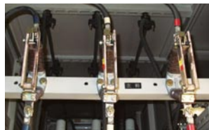
写真② 断路器 電力回路の無負荷時の電圧を開閉する機器。基本的に電流の開閉はできません。 (例)DS
