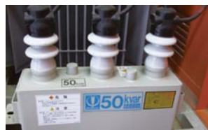
写真⑦ 高圧進相コンデンサ 受電設備の力率改善の為に設置されている機器です。 (例)SC
