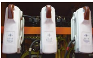
写真⑤ 高圧カットアウト 機器の開閉のためにヒューズを装着している機器です。 (例)PC PCSなど
