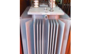
写真⑥ 変圧器 (単相変圧器 三相変圧器) 高圧を低圧に変成する機器です。 (例)1φTr 3φTr
