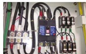
写真⑧ 配線用遮断器 過負荷や短絡など異常な電流が流れた時に電路を開放して負荷回路や電線を損傷から回避する為に用いる機器です。 (例)MCCB
