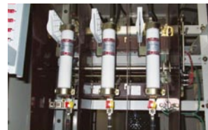
写真④ 高圧交流負荷開閉器 負荷電流の開閉と短絡電流の遮断のため、限流ヒューズが取り付けられている機器です。 (例)LBS
