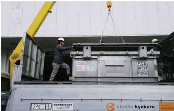
微量PCB含有機器を専用容器へ収納作業
