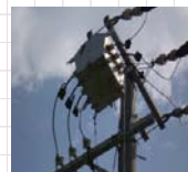
① 地絡継電器付高圧気中負荷開閉器 (GR付PAS)
