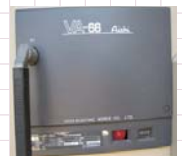
③ 真空遮断器 (VCB)
