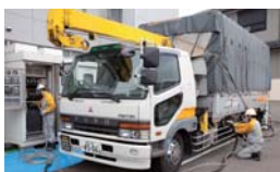
絶縁油の取替作業
