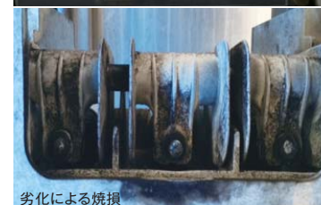
劣化による焼損
