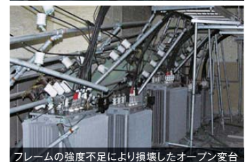
フレームの強度不足により損壊したオープン変台
