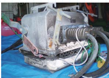
雷により焼損した高圧気中開閉器 (PAS)
