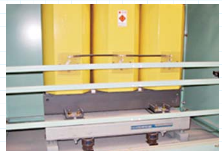
防振装置を取付けた変圧器 出典:日本防振株式会社
