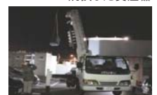
クレーン車にて吊上げ
