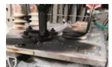
焼損した変圧器
