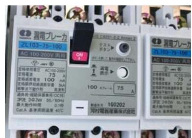
ポイント 漏電遮断器は漏電している回路を遮断する装置です。この回路が漏電しているとスイッチを入れてもすぐにトリップしてしまいます。漏電している回路を見つけて設備を修理しましょう。また、空調機を長く使用するためにはこまめな掃除が重要です。
