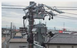
① 高圧気中負荷開閉器 (PAS)
