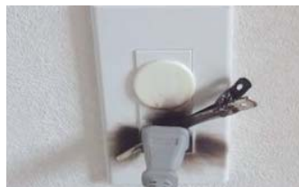
コンセントが短絡(ショート) (出典:東京消防庁)
