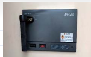
③ 真空遮断器 (VCB)
