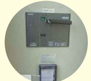
真空遮断器 (VCB)
