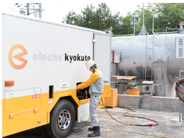
絶縁油取替作業用タンクローリー
