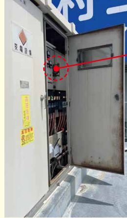
端子台の著しい絶縁低下により電流回路が生成。ZCT2次側のD種接地にかけて迷走電流が流入しGRが誤動作。
