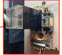
端子台の著しい絶縁低下により電流回路が生成。ZCT2次側のD種接地にかけて迷走電流が流入しGRが誤動作。
